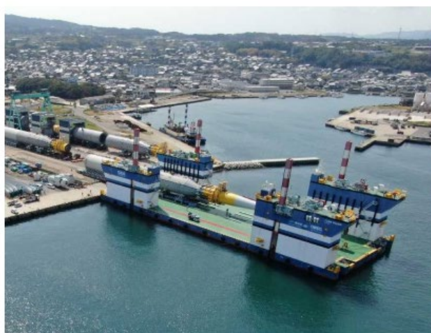
浮体積み込み状況
