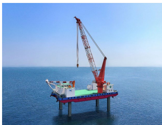
完成したSEP写真
