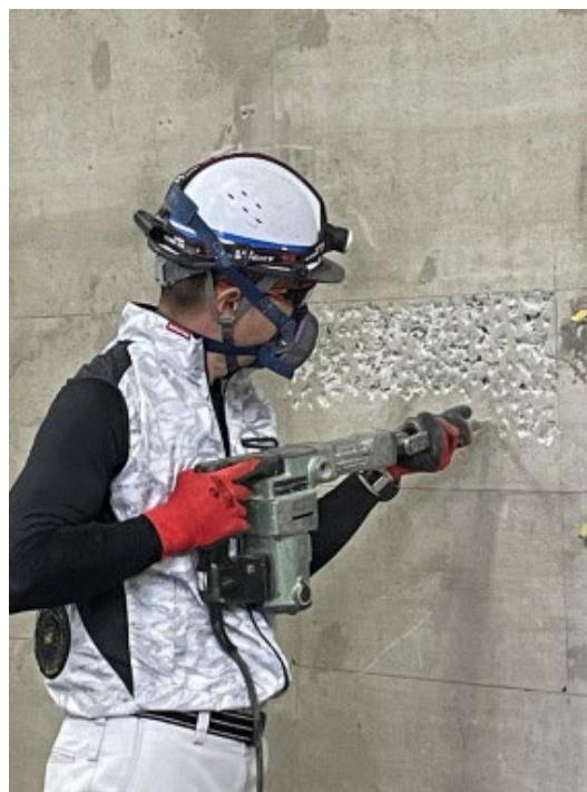
写真 2 チップング工法施工状況
