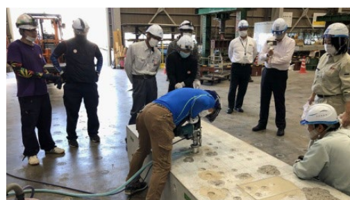
(b)施工講習会(実技講習)
