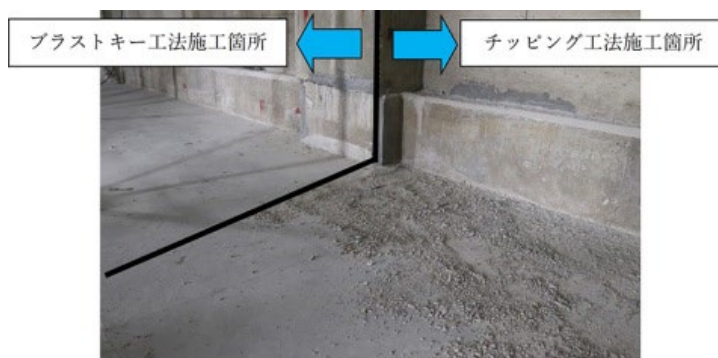
写真 3 ブラストキーとチップングのコンクリートガラの比較
