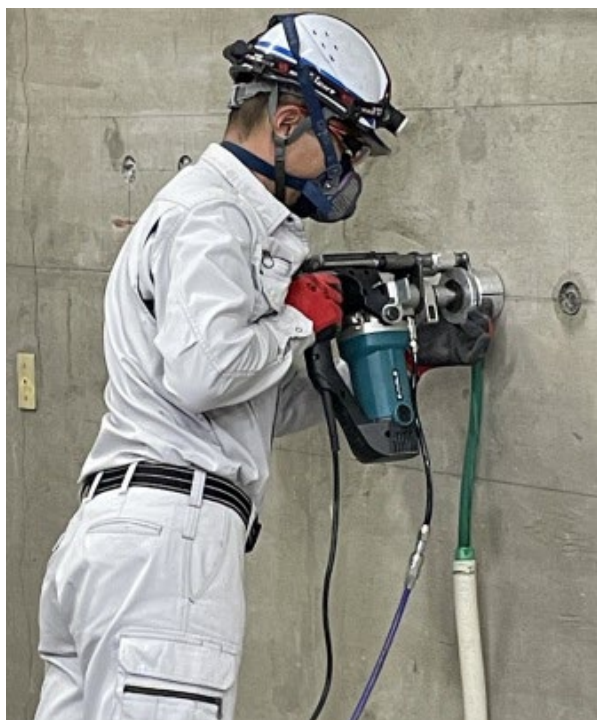
写真 1 ブラストキー工法施工状況
