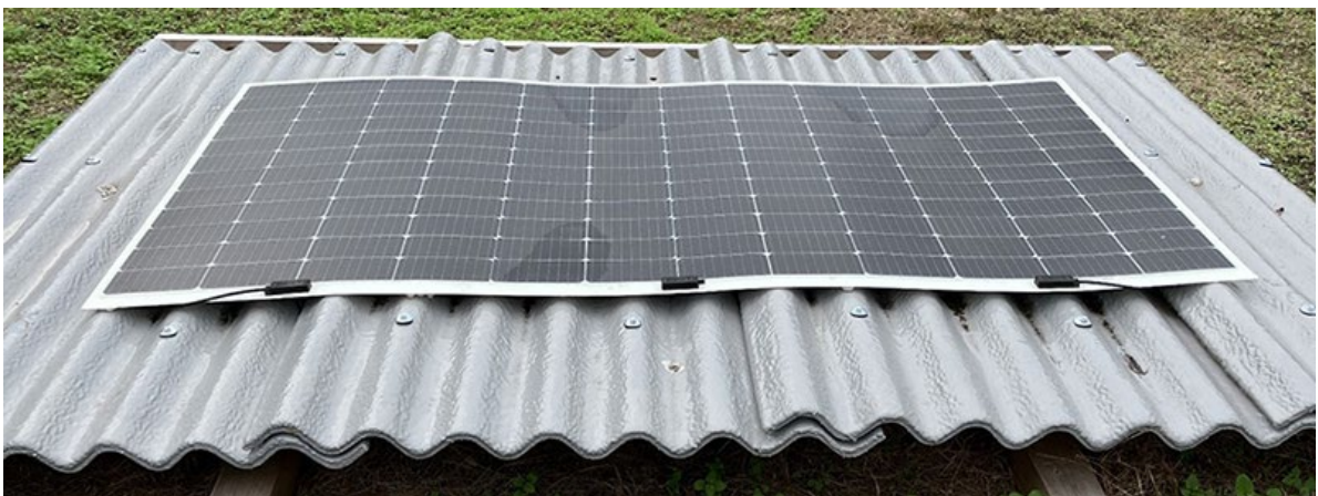
スレート屋根への設置検証の様子
