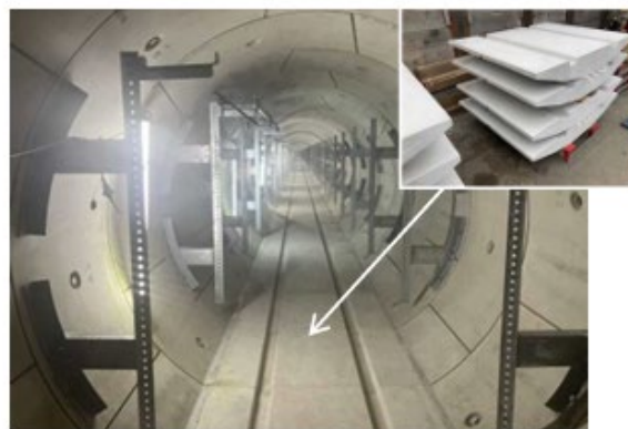
<据付後の状況>
